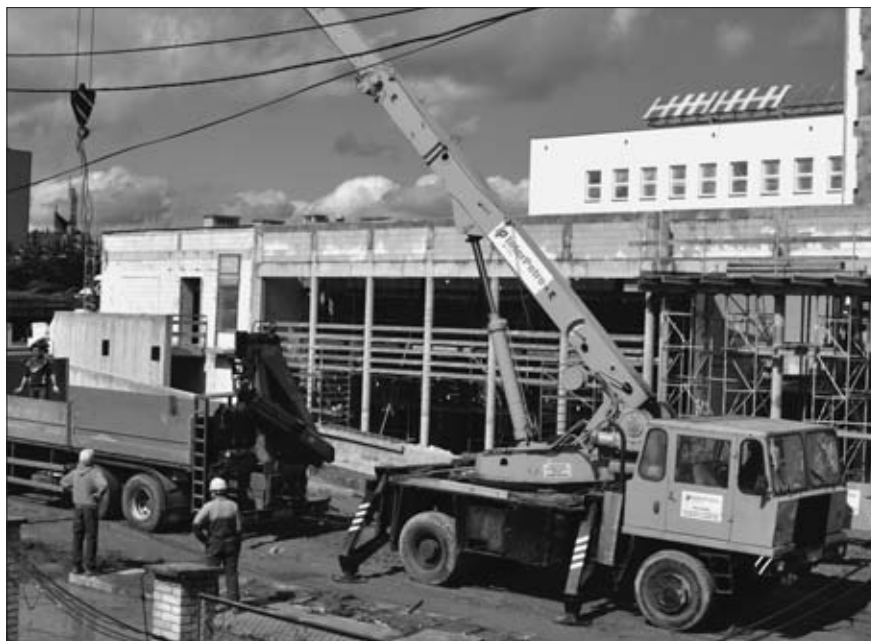
Ciężki sprzęt na placu budowy przy Szpitalu Wojewódzkim nr 2 w Rzeszowie.
