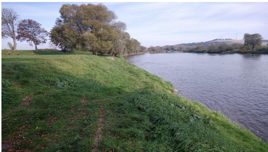
22. Dynów – proponowane miejsce pod inwestycję (brzeg).
