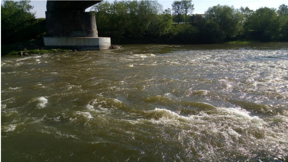
41. San w miejscowości Zgoda – most kolejowy.
