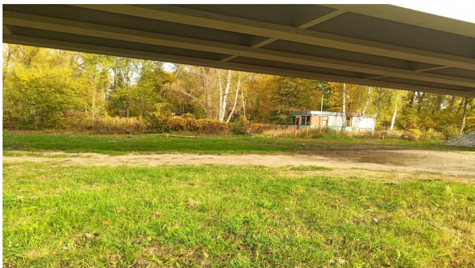
45. Zamknięty ośrodek wypoczynkowy w Ubieszynie.
